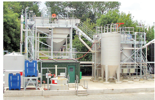
Схема, где перед подачей на фильтры DynaSand, вода обрабатывается на сепараторе Johnson Lamella
